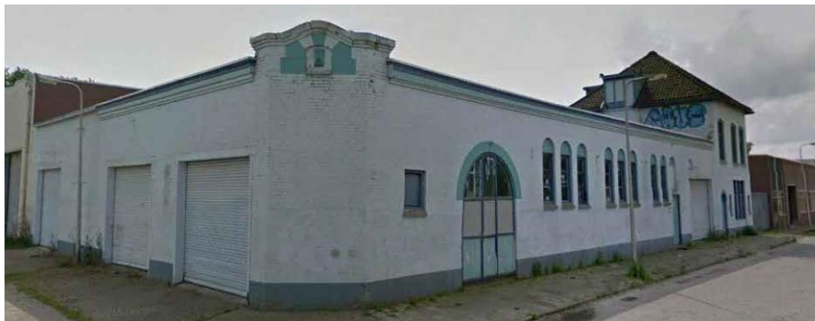
Figuur 2.3 Voormalig gebouw stoom- en machinewasserij De Ooijevaar
