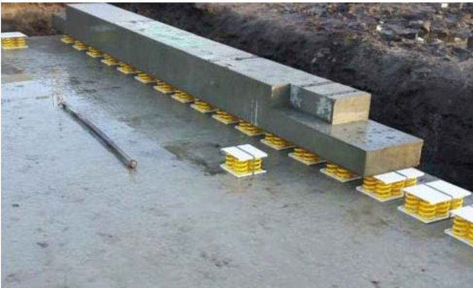
Figuur 36 Dubbele fundering met stalen veerdozen (project in Prinsenbeek)
