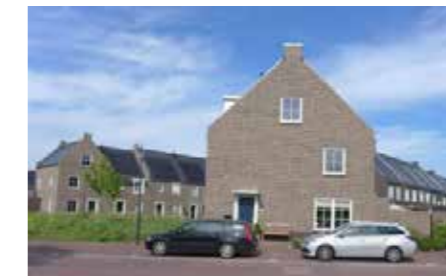
kopgevel als voorgevel met voordeur en tuinmuur
