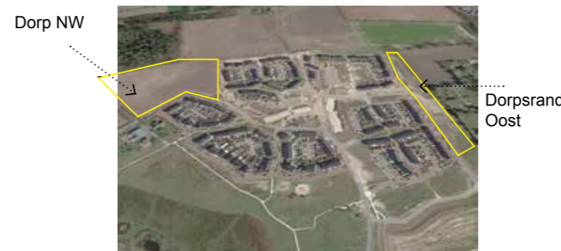
Dorp Steenbrugge in aanbouw stvz 2020
