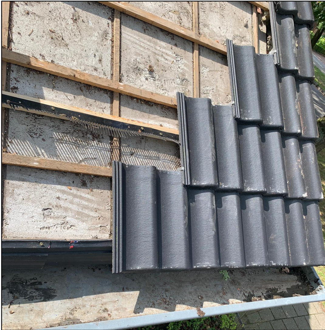
Figuur 11. Vogelschroot 1 rij pannen opgeschoven zodat huismussen voldoende nestgelegenheid hebben. Extra maatregel voor de locatie Noorderkroonstraat Enschede. Bron: Hemink Groep BV.
