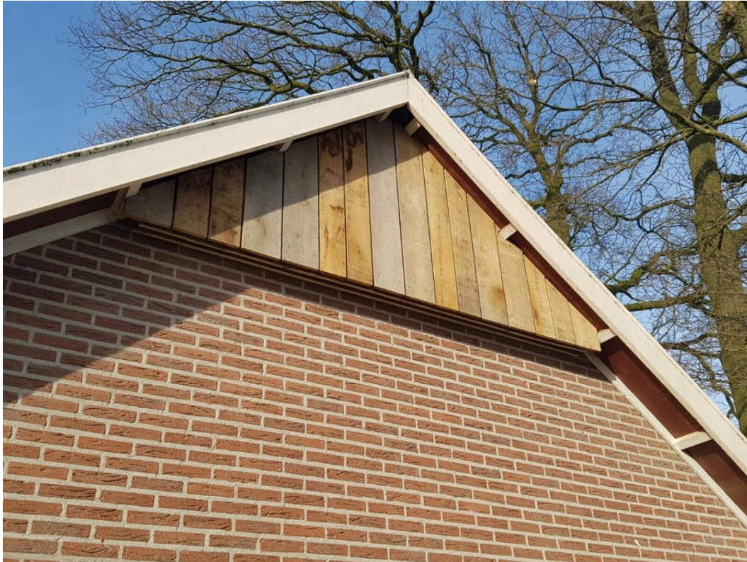
Figuur 5. Vleermuiskast door middel van gevelbetimmering met 3 ruimten achter het houtwerk. Bron: Eelerwoude 2019.
