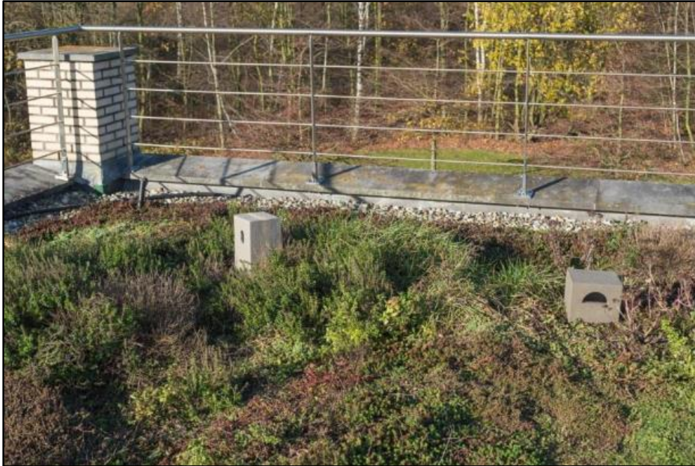
Figuur 8. Nestkasten voor zwarte roodstaart in combinatie met een groen plat dak. Bron: Arcadis, 2018
