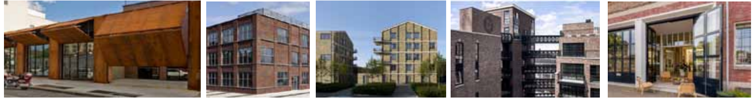
plot 7, stoere industriële architectuur, een ensemble van bouwdelen met een levendige plint met entrees en voorzieningen en/of woonorientatie
