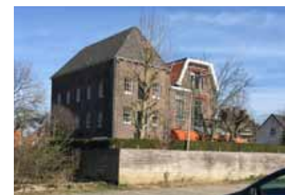
huidig aanzicht woonhuis en pakhuis gezien vanaf locatie voormalige sluis
