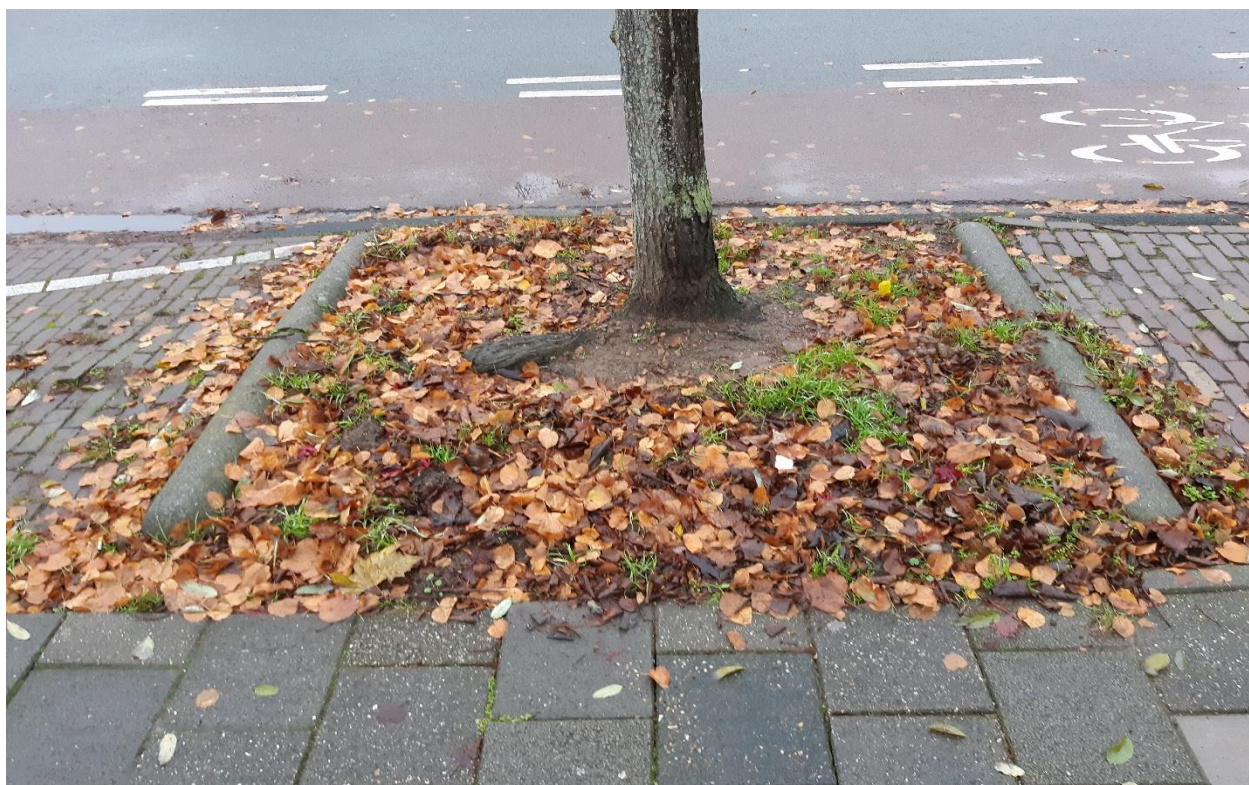
Figuur 3 Groeiplaats van de boom: Nagenoeg onbegroeide boomspiegel van 2 x 2 meter rondom afgezet met verschillende soorten betonnen afsluitbanden. Te zien is dat de straatstenen aan weerszijde van de boom zijn opgedrukt door de boomwortels (links en rechts op de foto).
