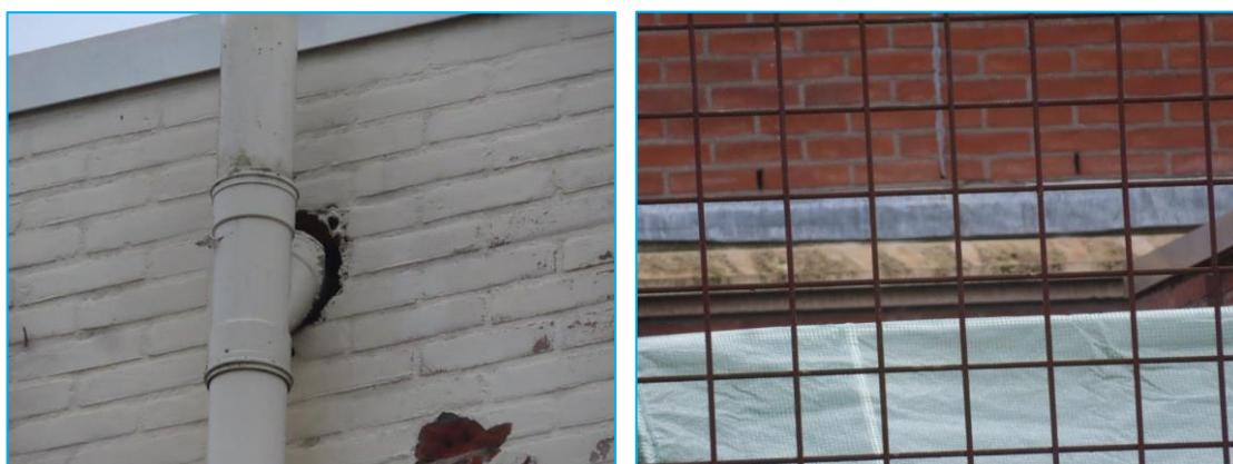
Foto's: Openingen die toegang kunnen bieden naar mogelijke vaste verblijfplaatsen van vleermuizen.
