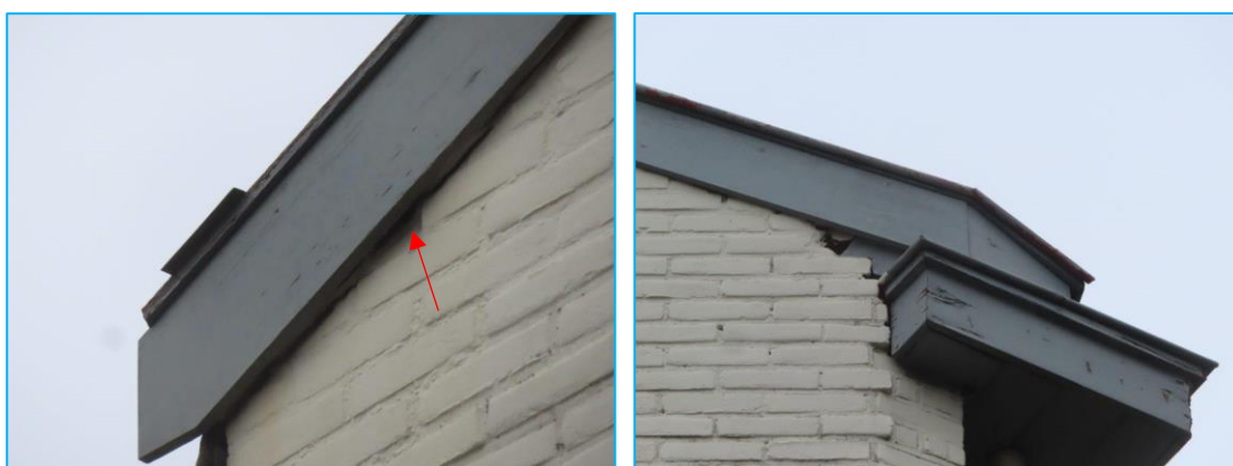
Foto's: Openingen die toegang kunnen bieden naar mogelijke vaste verblijfplaatsen van vleermuizen.
