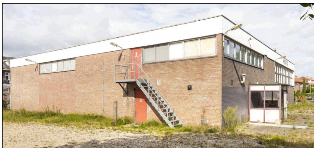
Afbeelding 2.2b: Impressie van de huidige onderzoekslocatie, zuidzijde pand met deel parkeerplaats (bron: terreininspectie verkennend onderzoek 2020)
