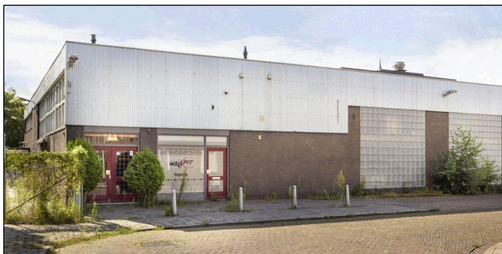
Afbeelding 2.2a: Impressie van de huidige onderzoekslocatie: noordzijde pand aan de Murmelliusstraat (bron: terreininspectie verkennend onderzoek 2020)
