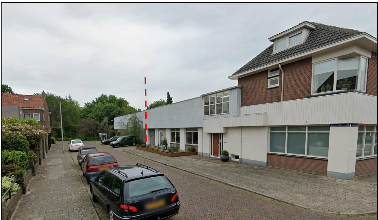
Zicht vanaf de Erasmusstraat richting het plangebied (achter de stippellijn), met op de voorgrond de bebouwing aan Murelliusstraat 2.
