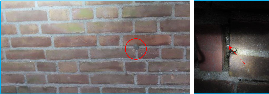
Foto's: Indicatie van na-isolatie.
