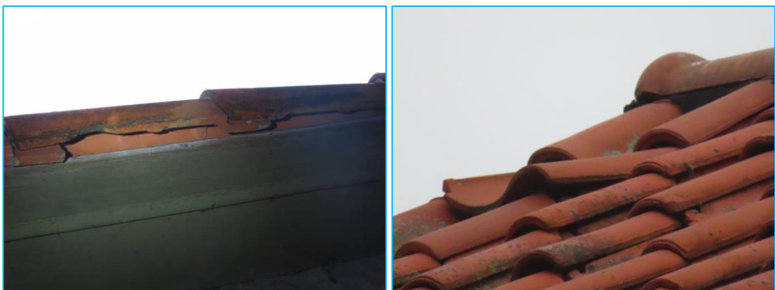
Foto's: Potentiële broedplekken voor gierwaluw/ huismus.
