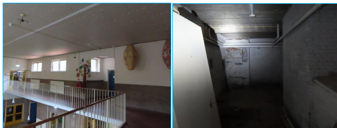
Foto's: Indrukken plangebied. Binnen en kelder voormalig schoolgebouw.
