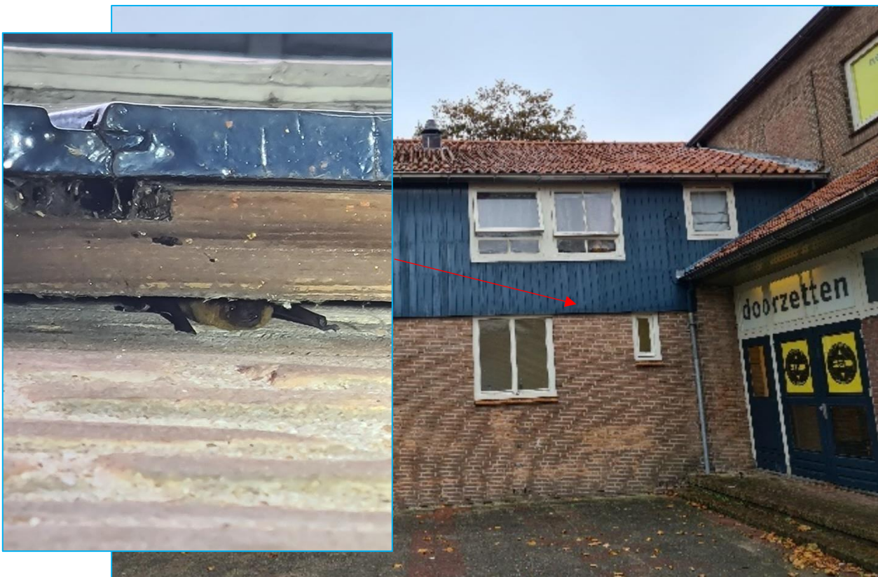
Foto's: Dwergvleermuis achter gevelbetimmering.
