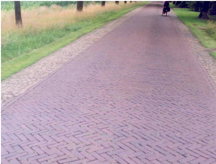
Principe-inrichting van de rijbaan: gebakken klinkers met een bies van natuursteen aan weerszijden (beeld afkomstig uit stedenbouwkundig plan WEST8 / gemeente, 2006)
