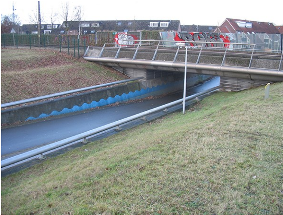
Fietstunnel onder de spoorlijn richting Almelo.
