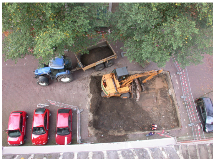
Figuur 27: De aanleg van het eerste vlak in werkput 2.
