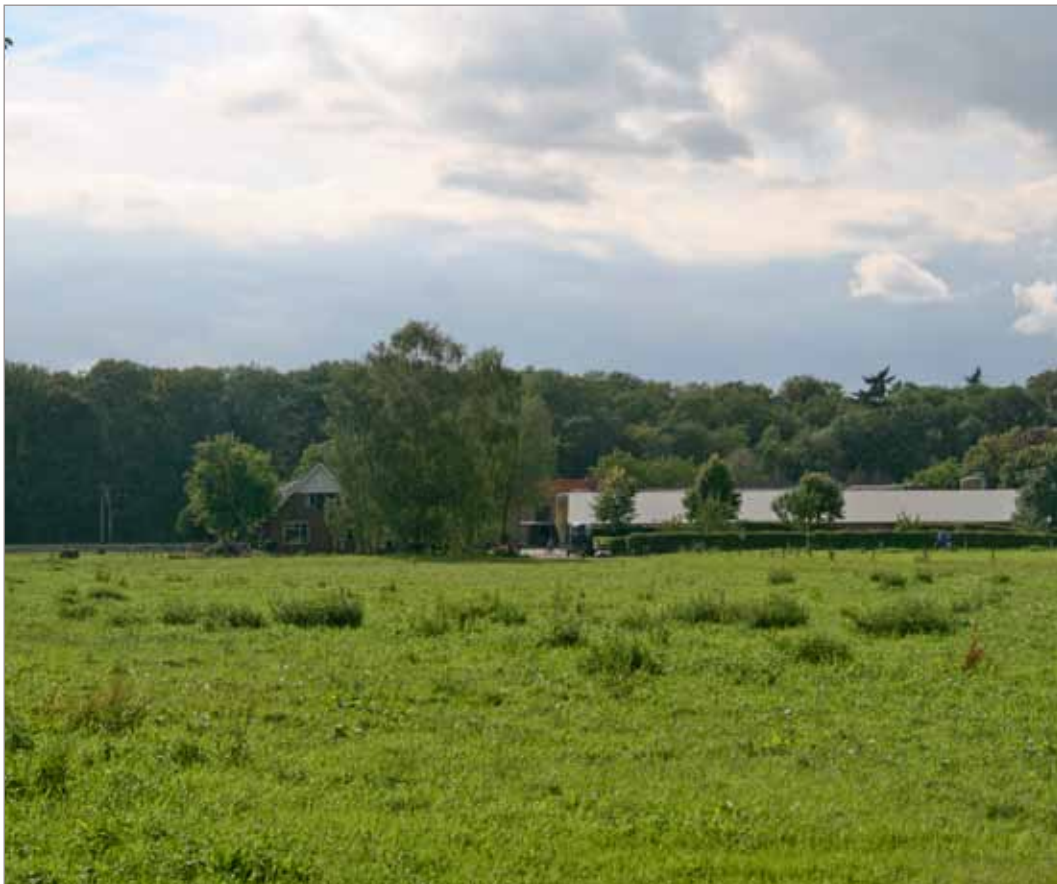
Afbeelding 7. Te slopen bebouwing
