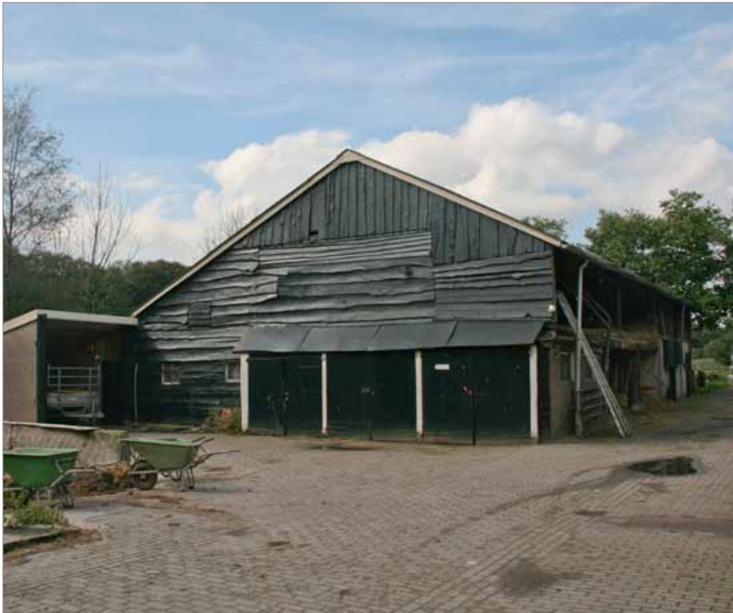
Afbeelding 2. Te slopen bebouwing
