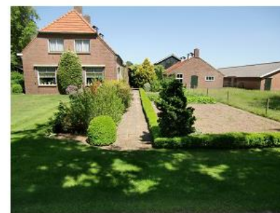
Voorgevels van de boerderij en bakhuis/varkensschuur
