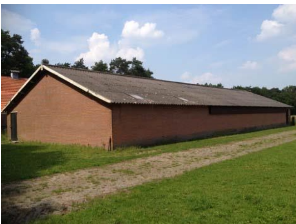
Foto 5. Stal E vanaf het zuiden gezien.
