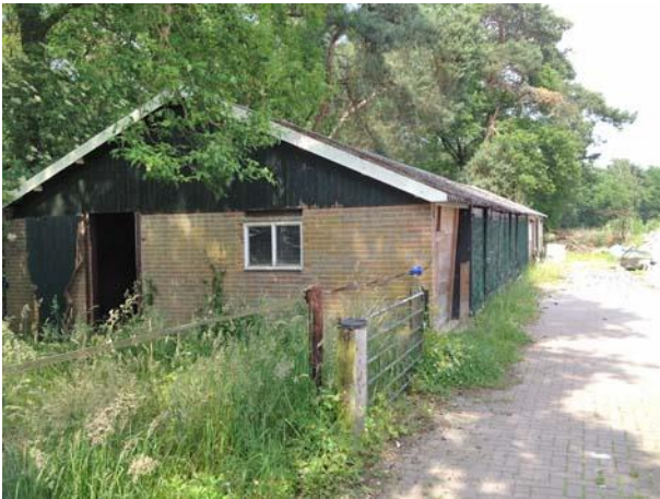
Foto 3. Noordzijde erf met de te slopen schuur B.
