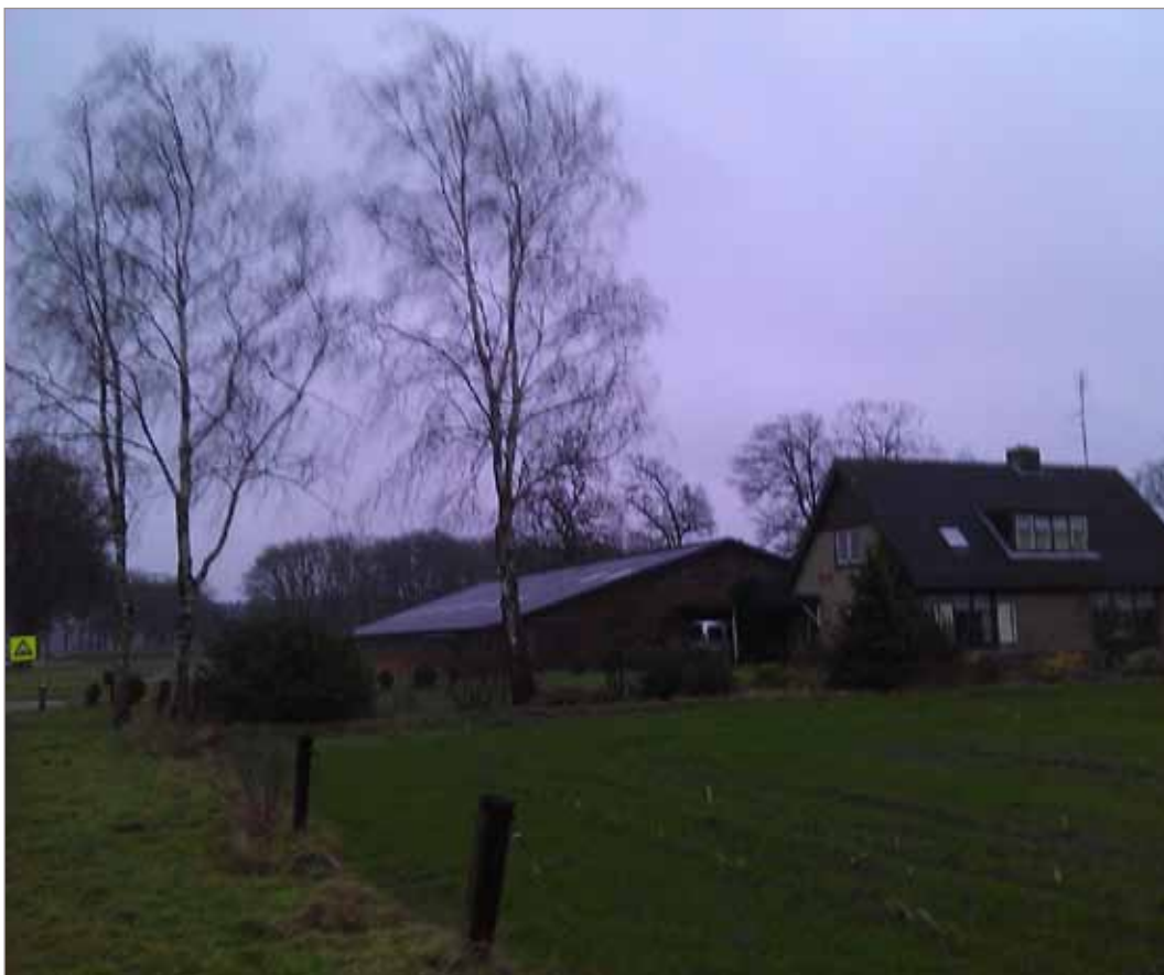
Afbeelding 7. Te slopen bebouwing aan de Cröddendijk
