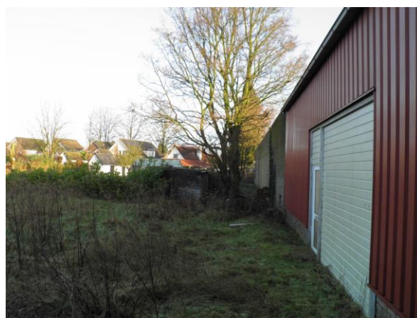
Figuur 4. Achterzijde/westkant van de gebouwen.
