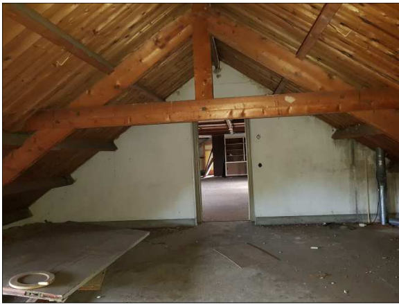
Figuur 7. Structuur van de zolders van het complex
