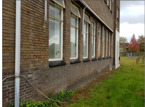
Figuur 6. Gevel zuidvleugel van het complex
