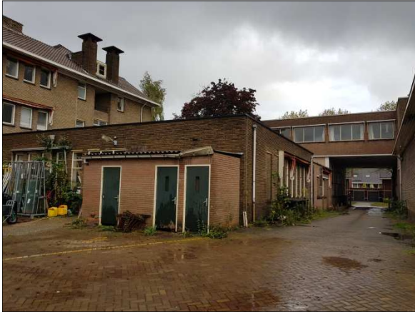
Figuur 5. Boilergebouw oostzijde van het complex
