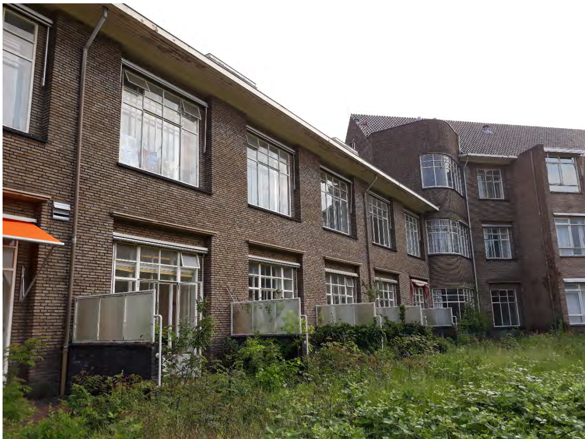
Zicht op bestaand gebouw, nabij boring 306
