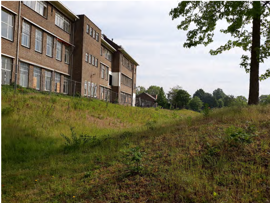
Zuidoostzijde van bestaand gebouw, zicht op braakliggend terrein
