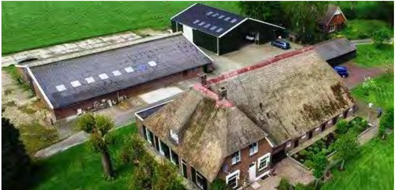
te slopen opstallen (ligboxenstal en wagenberging)
