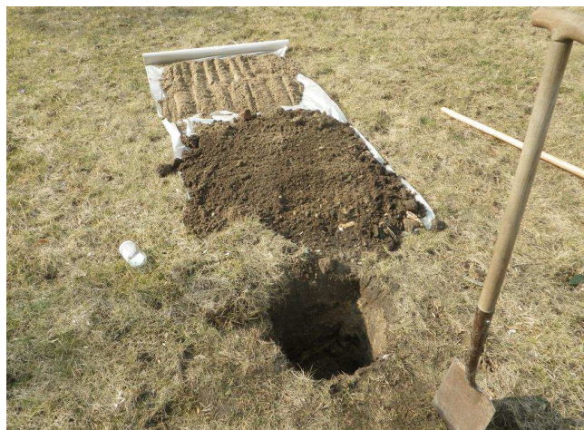
Foto 4: asbestgat bij boornummer 2
