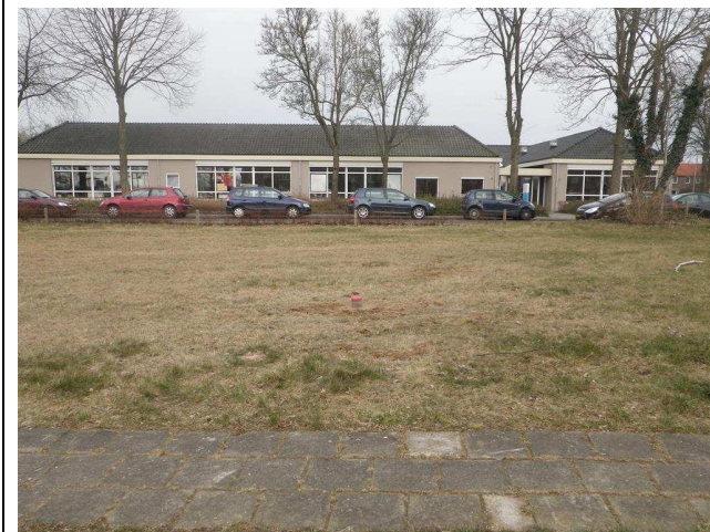
Foto 9: asbestgat bij boornummer 9
