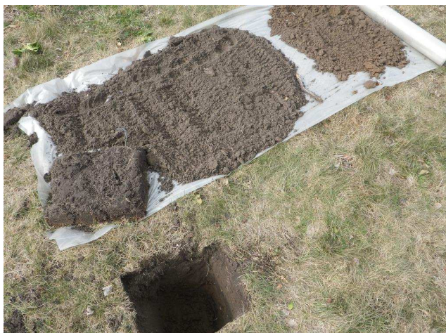
Foto 5: asbestgat bij boornummer 5
