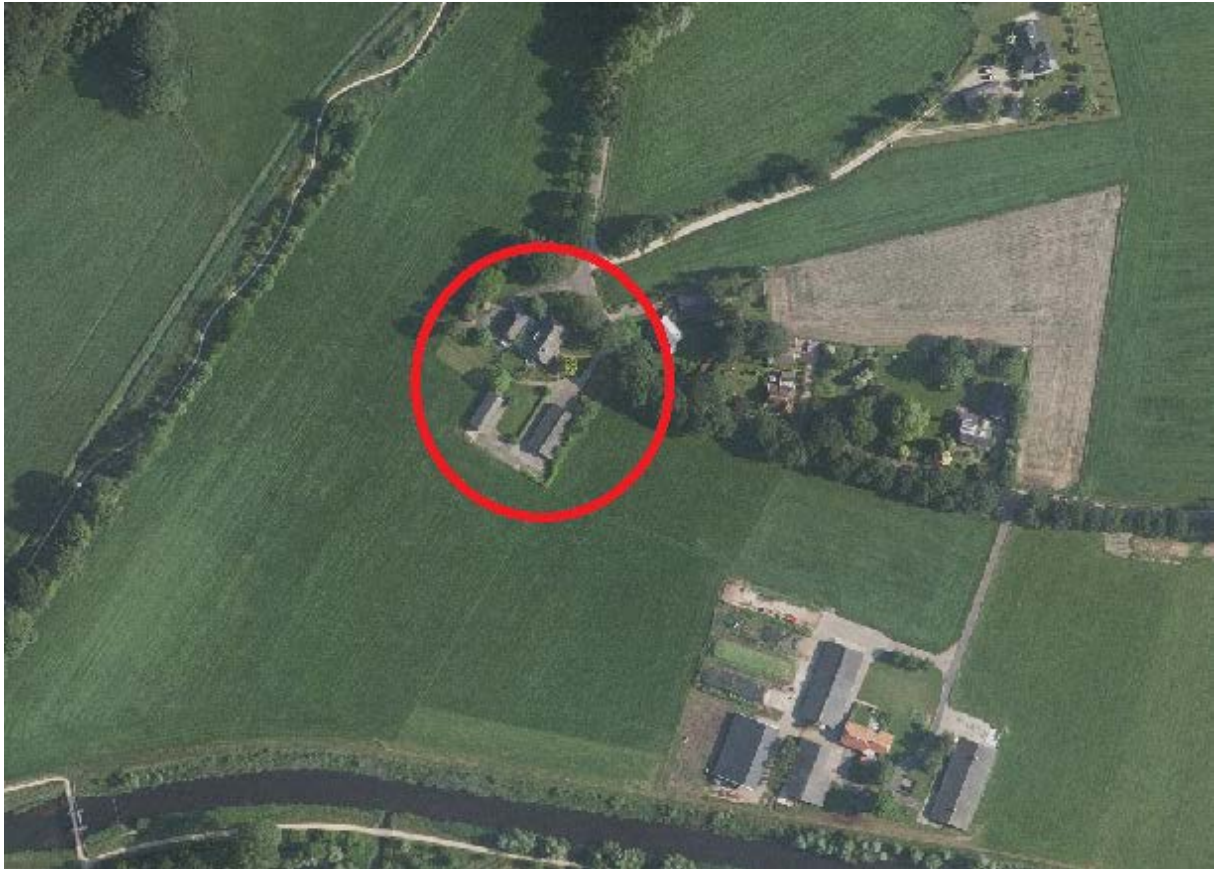
Luchtfoto van de huidige situatie en directe omgeving.
