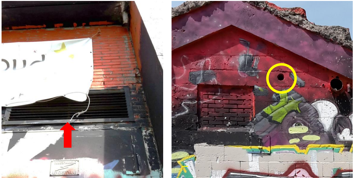
Figuur 3.1 en 3.2 Potentiële verblijfplaatsen van vleermuizen, bereikbaar via rooster (rode pijl) en gat (gele cirkel) in het tribunegebouwtje. Foto's: Arno Kuipers, Ecogroen.
