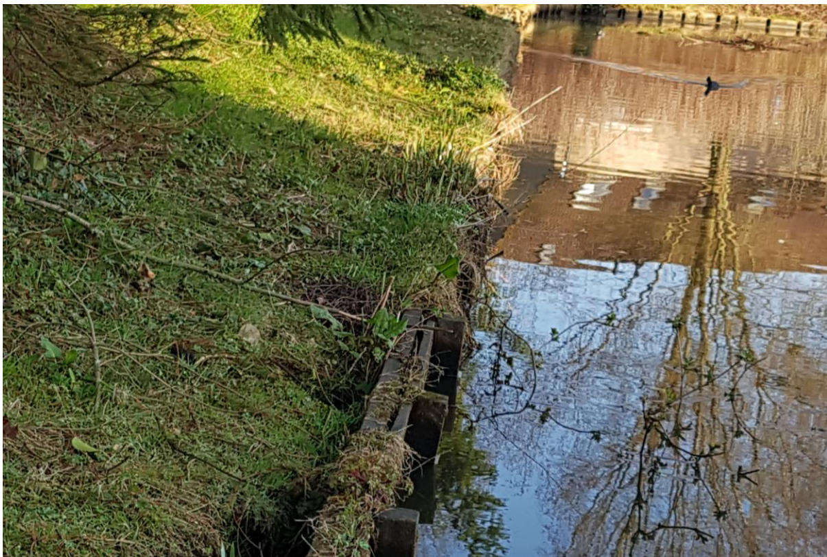
Figuur 5.10. Houten oeverbeschoeiing langs watergang nabij de onderzoekslocatie.
