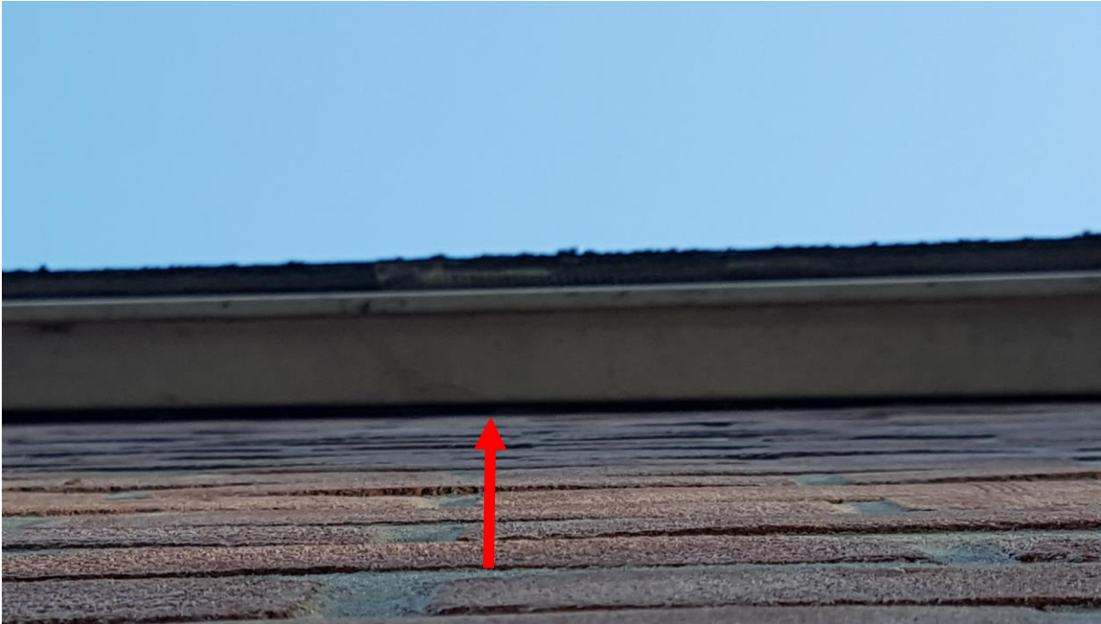
Figuur 5.9. Ruimte tussen muur en windveer in te slopen garagebedrijf (bron: Eco Reest).
