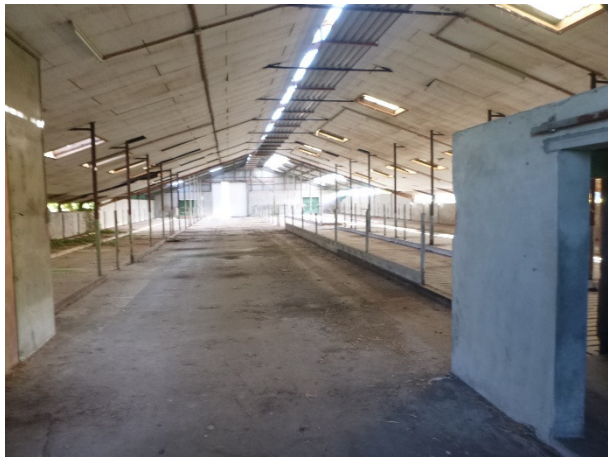
Binnenzijde voormalige ligboxenstal
