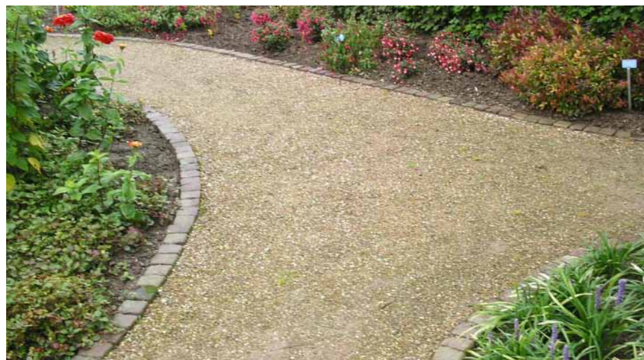
Afbeelding 46. Referentie halfverharding erf van fijn grind
