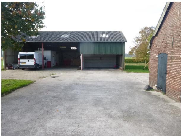
Kapschuur met koelcellen en werkplaats
