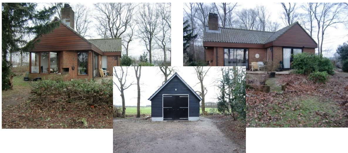
Foto's van de bestaande situatie van de woning en bijgebouw
