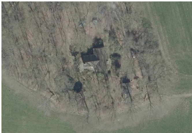
Figuur 1: Luchtfoto van de huidige situatie Bloemenkampsweg 6
