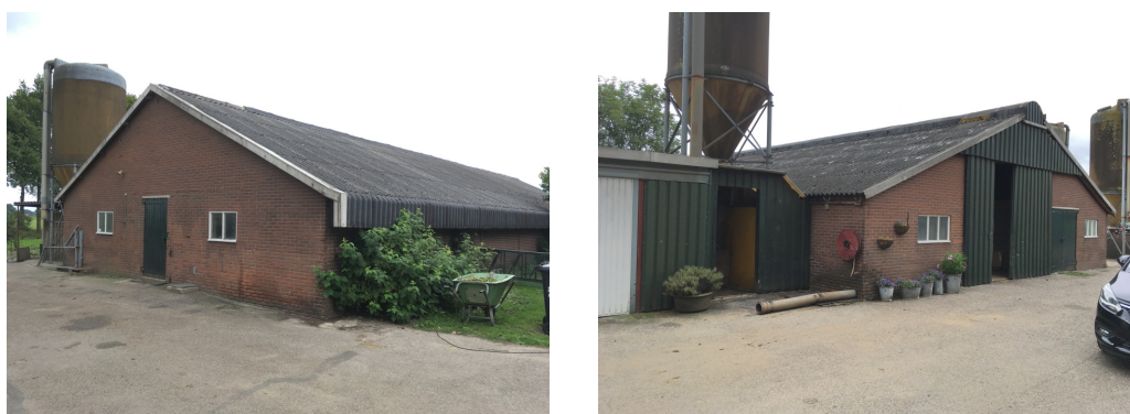
Figuur 6 & 7. Gebouwen ten zuiden van de oprit met links de kippenstal en rechts de koeienstal.
