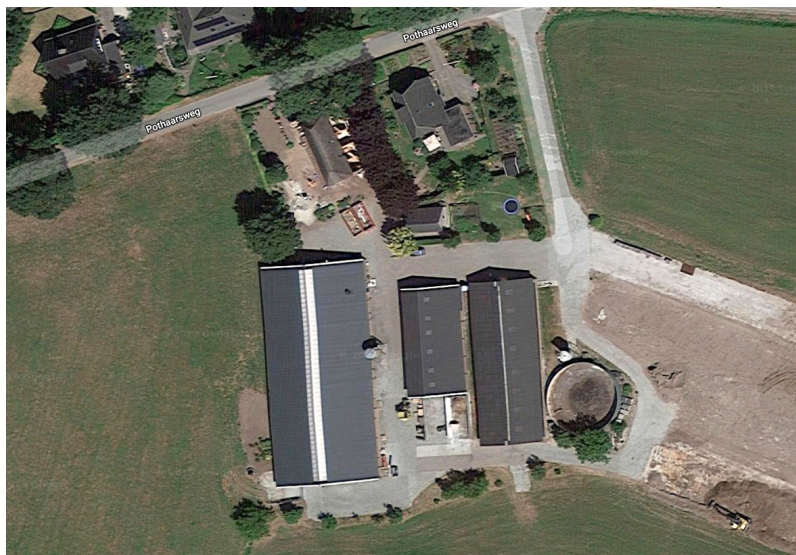
Figuur 3. Recente luchtfoto van het plangebied aan de Pothaarsweg 2.
