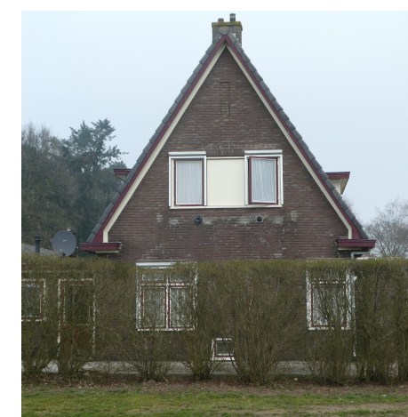
Foto westgevel bestaande bedrijfswoning
