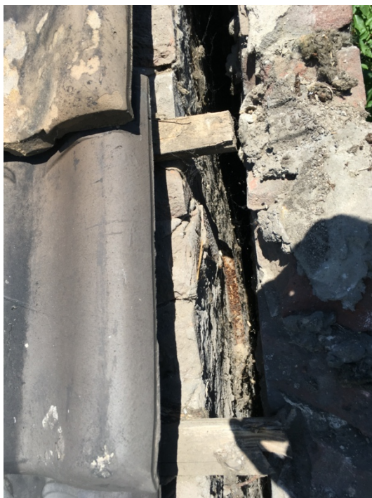
Figuur 4 Spouw van de oostgevel.
