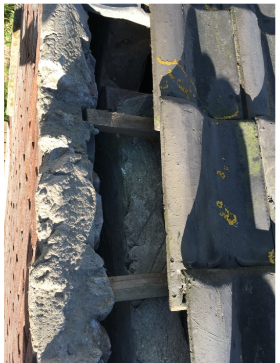
Figuur 3 Spouw van de westgevel.
