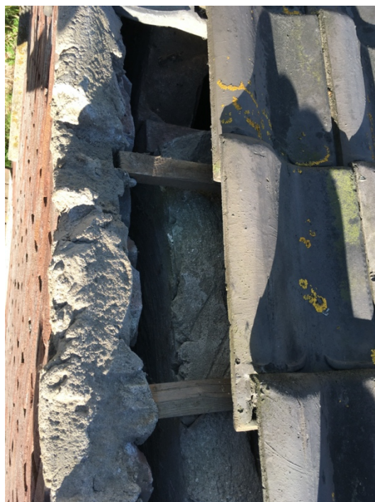
Figuur 13 Spouw van de westgevel.
