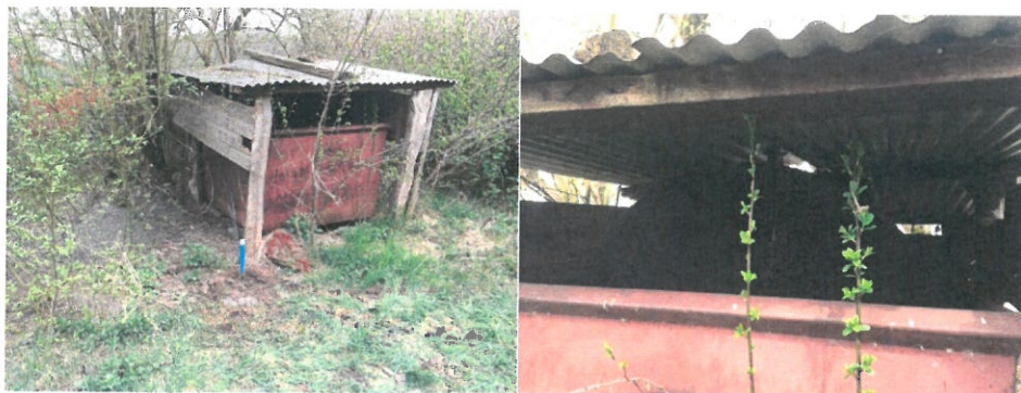
Foto 4.1: Boring 1 situering bovengrondse tank
