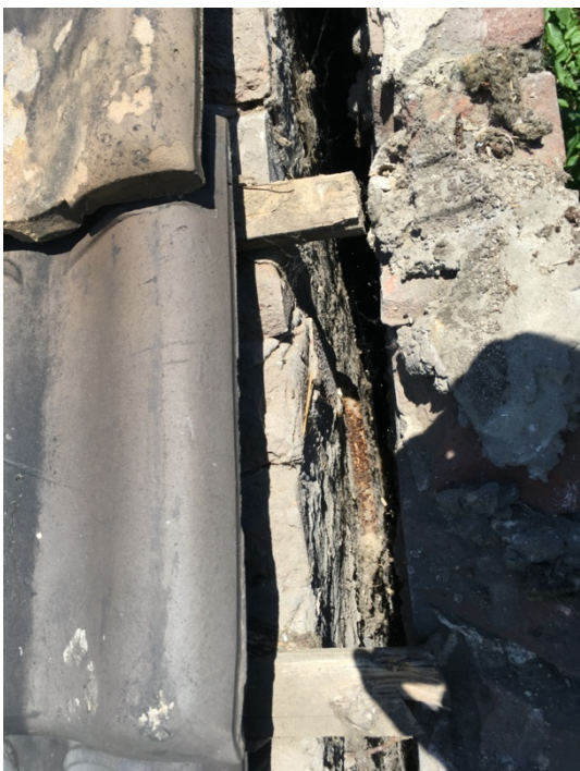
Figuur 12 Spouw van de oostgevel.
