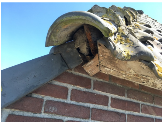
Figuur 10 Beginnokvorst van de westgevel.
