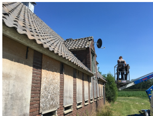
Figuur 9 Inspectie met hoogwerker.
