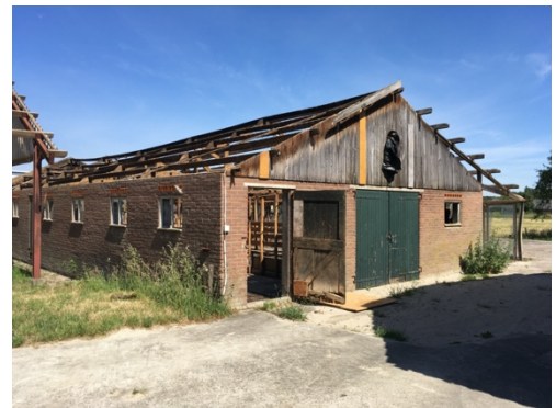
Figuur 6. Zuidzijde oostelijke stal.
