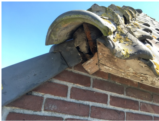
Figuur 2 Begijnokvorst van de westgevel.
