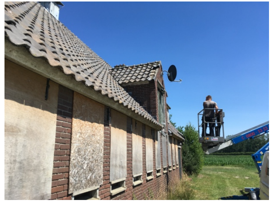
Figuur 1 Inspectie met hoogwerker.
