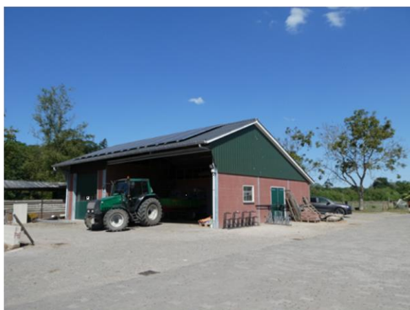
Figuur 6, foto van de bestaande kapschuur
