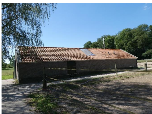
Figuur 5, foto van bestaande kippenschuur
