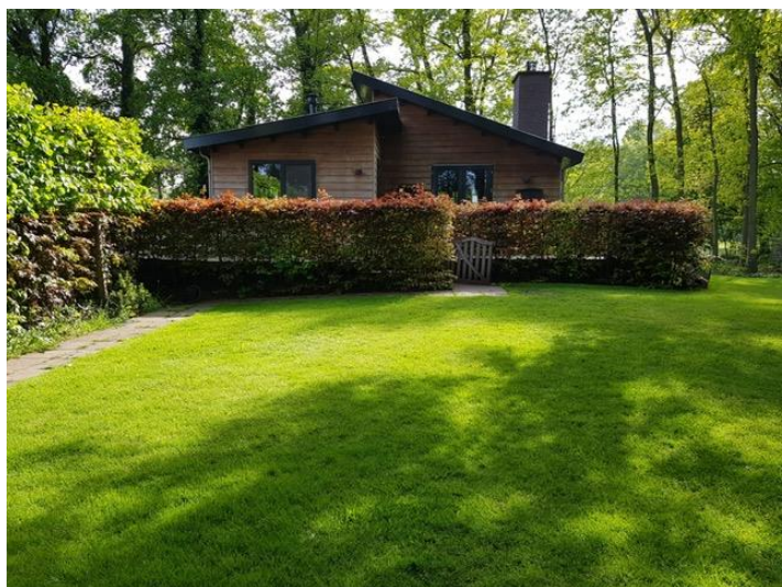
Foto van de bestaande woning
