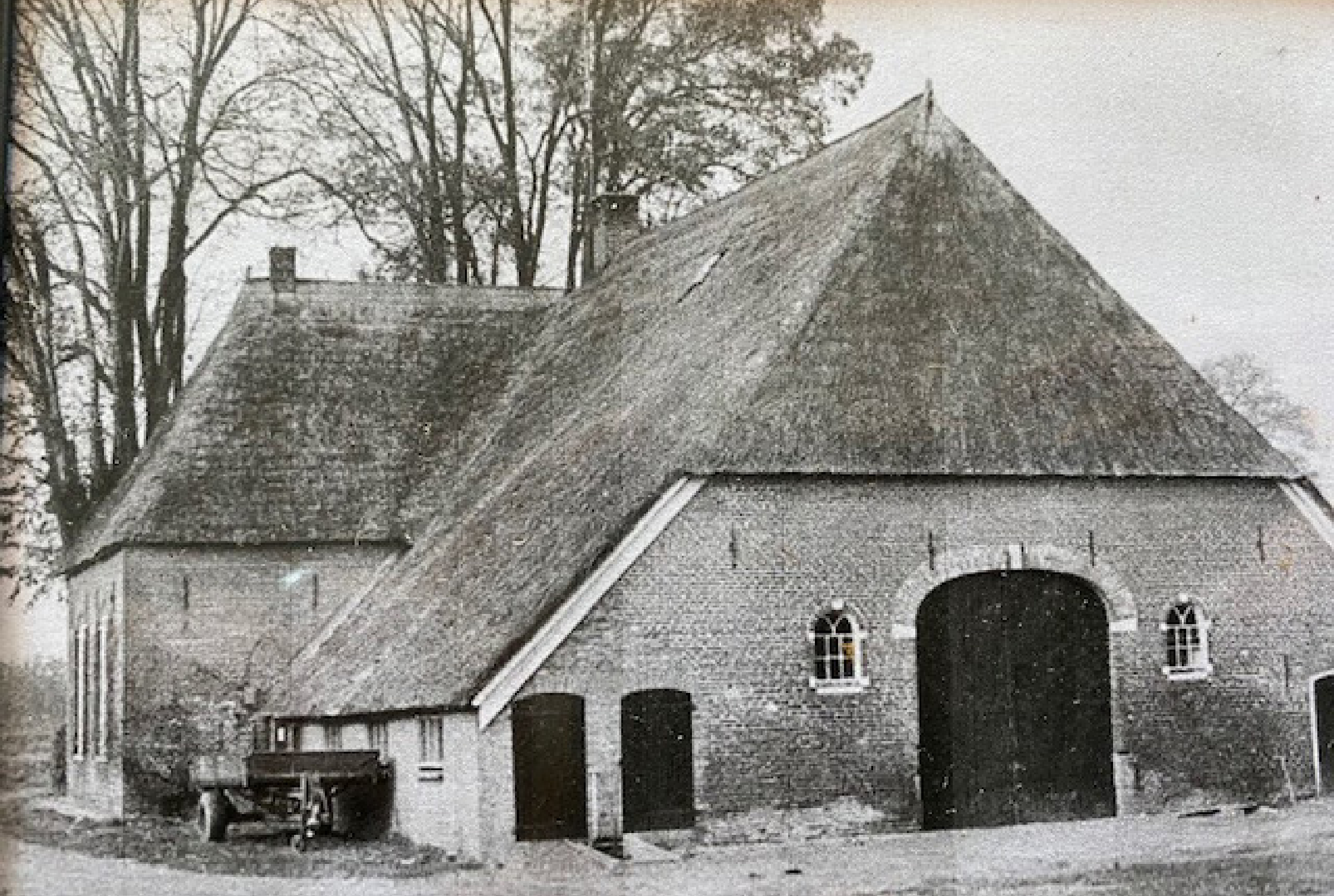
afbeelding 11. Foto van de oorspronkelijke achtergevel. Deze wordt in ere hersteld
