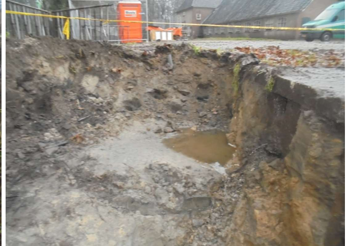
foto 14: Eindsituatie wand W7-1 en slibvang (rechts) (17-12-2018)
