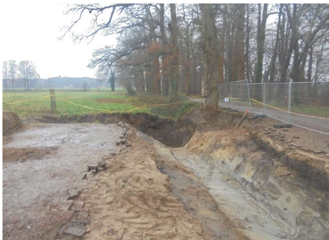
Foto 11: Eindsituatie richting wand W4a-1 (17-12-2018)
