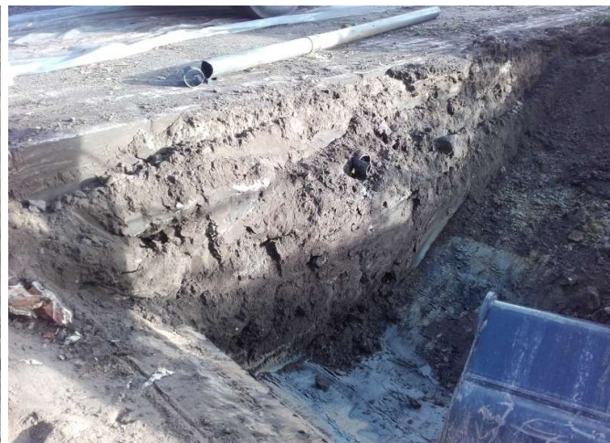
foto 2: Wand 2-1/2-2 en gedempte sloot (30-11-2018)
