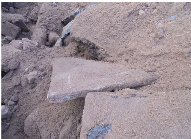
foto 5: Asbest uit zuidelijk deel van de ontgraving (14-12-2018)
