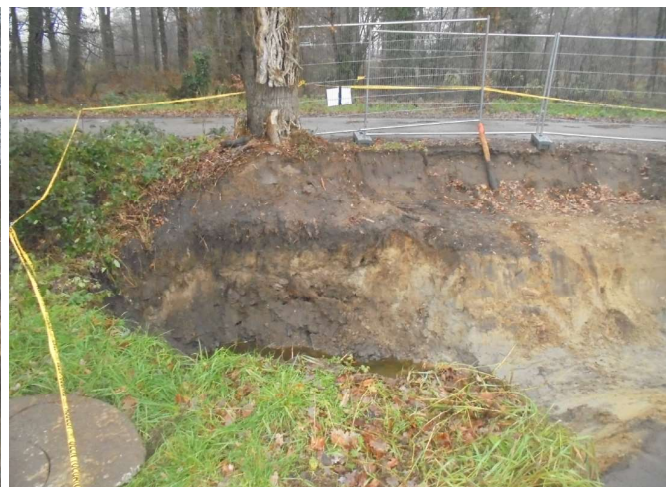
foto 12: Eindsituatie richting wand W1-1/W1-2 (17-12-2018)
