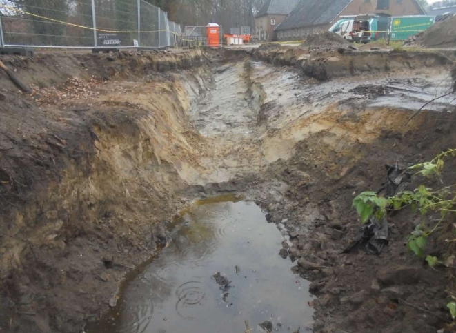
foto 13: Eindsituatie richting wand W7-1 (17-12-2018)
