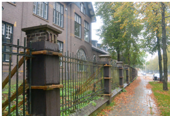
voormalige onderdoorgang vanaf Ceintuurbaan
