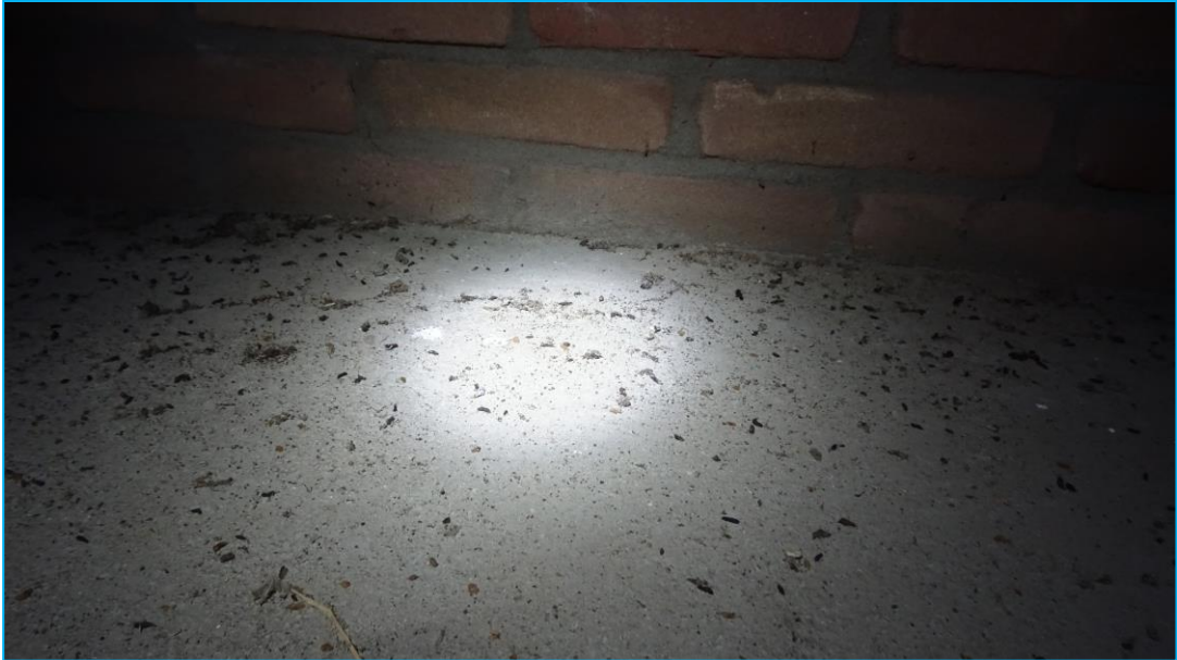
Foto: Uitwerpselen en afgebeten vlindervleugels van gewone grootoorvleermuis oostelijke nok.
