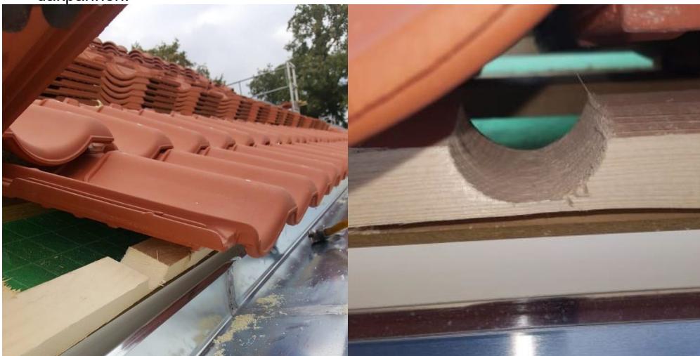
Figuur 5.1 Dakpannen met voldoende ruimte voor huismussen om te nestelen
