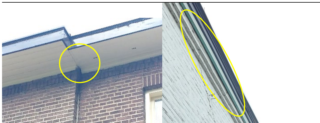
Figuur 3.1 Enkele voorbeelden waar vleermuizen toegang hebben tot een potentieel geschikte verblijfplaats
