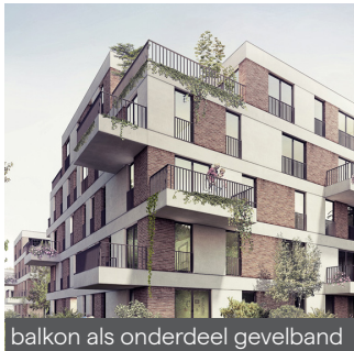
balkon als onderdeel gevelband
