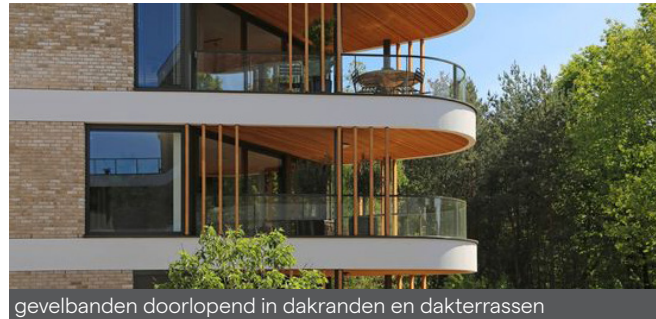
gevelbanden doorlopend in dakranden en dakterrassen
