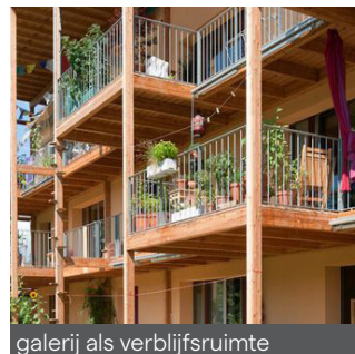
galerij als verblijfsruimte
