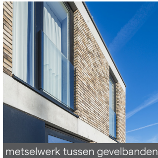
metselwerk tussen gevelbanden
