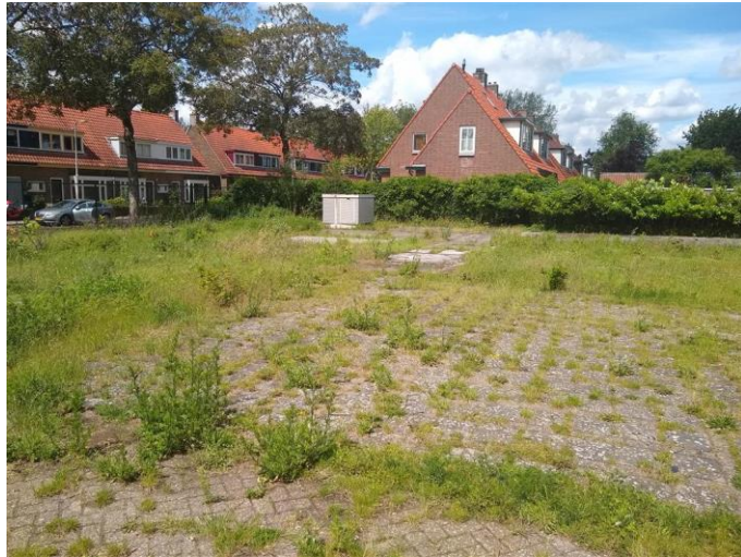
Foto 1 Klinkerverharding noordelijk terrein
