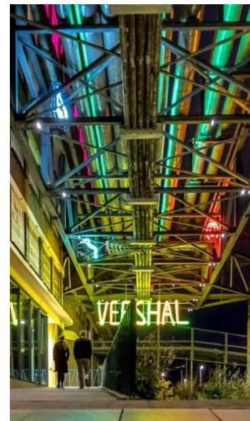
Verlichting gekoppeld aan brug
