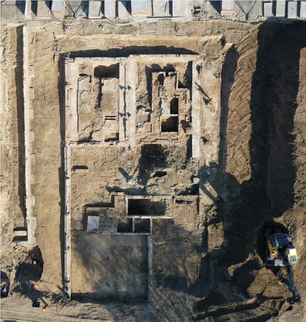
Afb. 7: De funderingen van de watergasfabriek.
