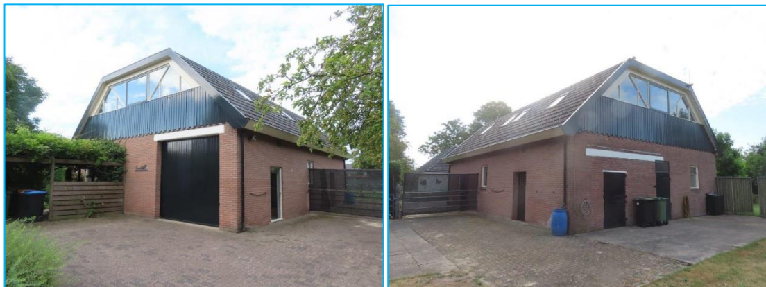
Foto's: Indrukken plangebied. De te verbouwen schuur.
