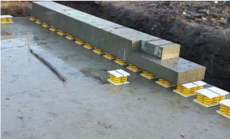
Figuur 20 Dubbele fundering met stalen veerdozen (project in Prinsenbeek)
