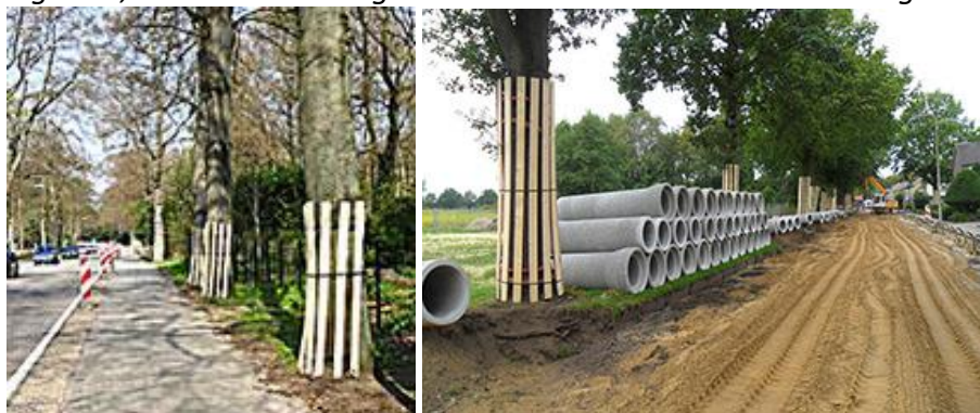
Figuur 4, voorbeeld bovengrondse boom beschermende maatregelen.
