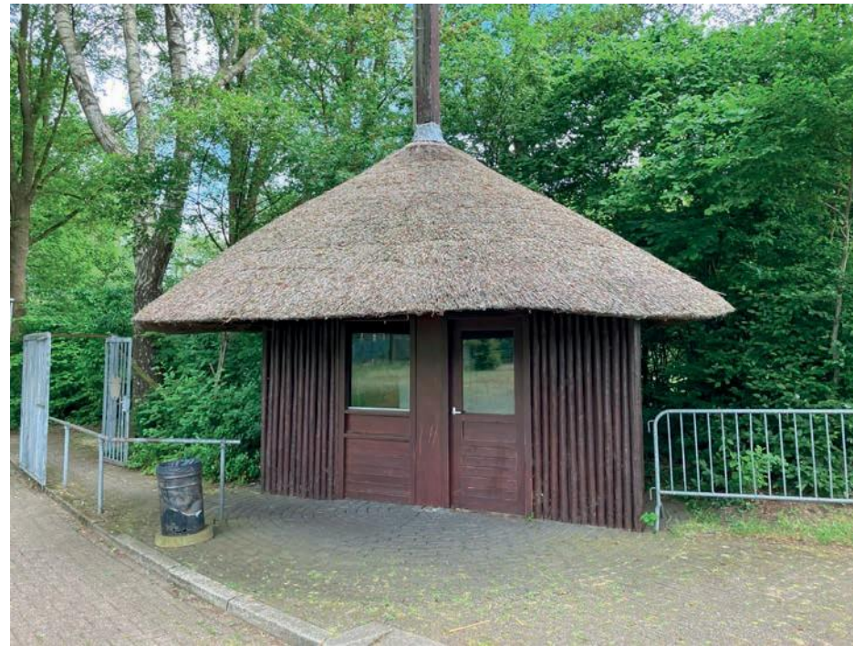
het kassagebouw of de 'hooimijt'
