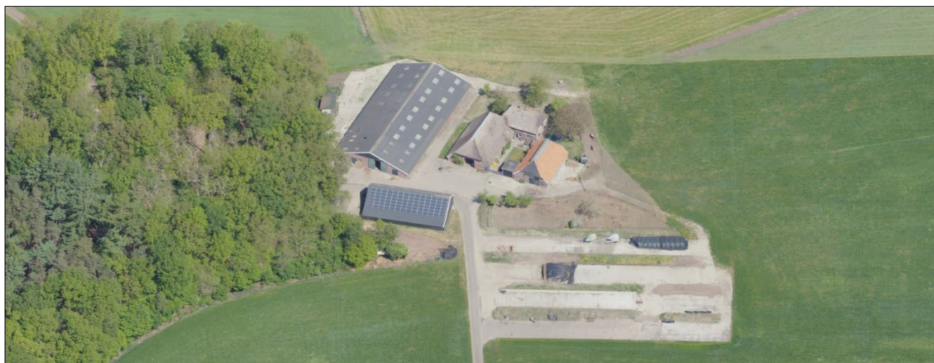
Afbeelding 7 De bestaande situatie van het plangebied (bron: Streetsmart, foto 2022)
