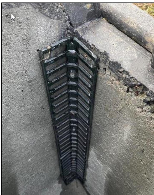
Figuur 6.12 Hoektrap in straatkolk als uitklimvoorziening voor amfibieën. Bron: RAVON.nl, 2023.
