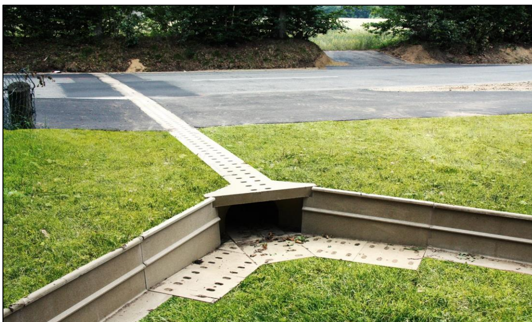
Figuur 6.11 Voorbeeld van een faunapassage en bijbehorende geleidende structuren. Foto: Acopro.be, 2023.
